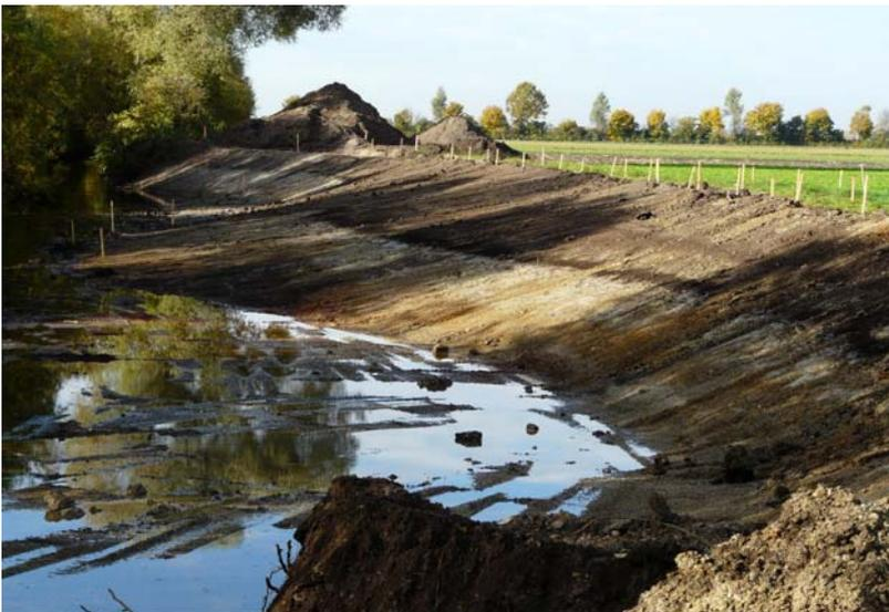
Durch den Ufer- und Geländeabtrag auf einer Länge von ca. 100 m und einer Breite von 10 m wird derzeit am Hauptkanal östlich von Josephenburg ein Retentionsraum mit einem Volumen von ca. 386 m<sup>3</sup> geschaffen.
